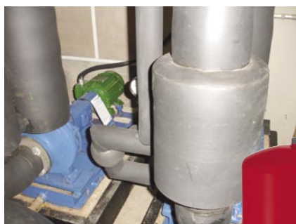
Acima, difusores de alta indução e CAG; abaixo, detalhe de tubulação isolada e tanque de expansão
